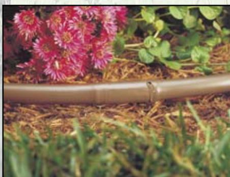
**10.** Desenrolle la tubería y conecte todos los elementos del sistema de riego localizado; consulte el esquema "Anatomía de un sistema de riego de bajo volumen Rain Bird".
